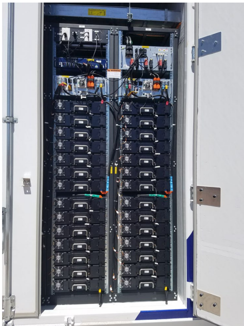
14 Battery Modules Per Rack
